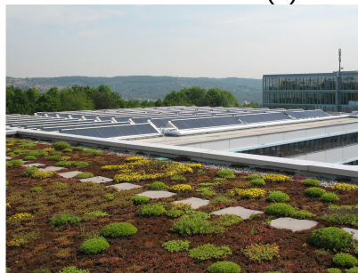
Bild 1, 2 Esslingen, 1.330 m 2 Bruttokollektorfläche zur Kühlung und Heizung
