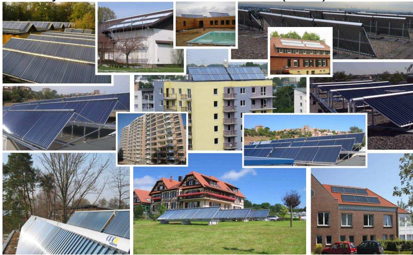
Bild 8 Große thermische Solaranlagen zur Warmwasserbereitung und Raumheizung
